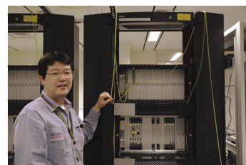
光クロスコネク (OXC: Optical Cross Connect) は、中継回線相互の接続を切り替える装置 (電気信号に変換する電子的なクロスコネクと光信号のまま切り替えることができる光クロスコネクの2種類があります)。
