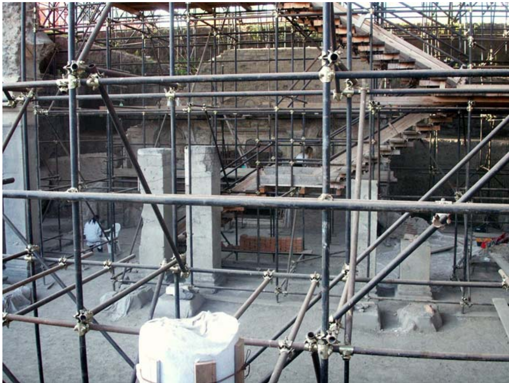
中央広間の南壁修復作業 09.2006
