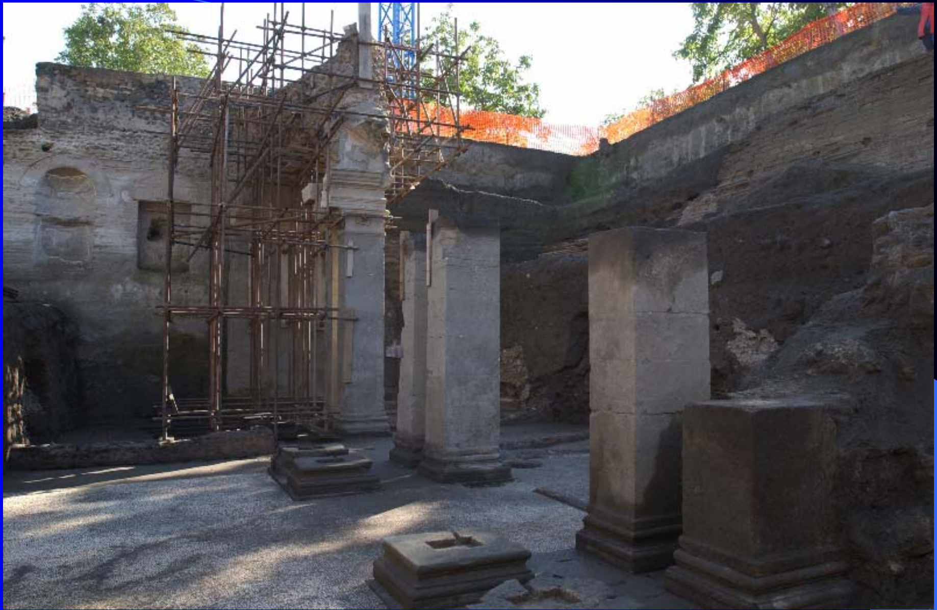
連続アーチ門
