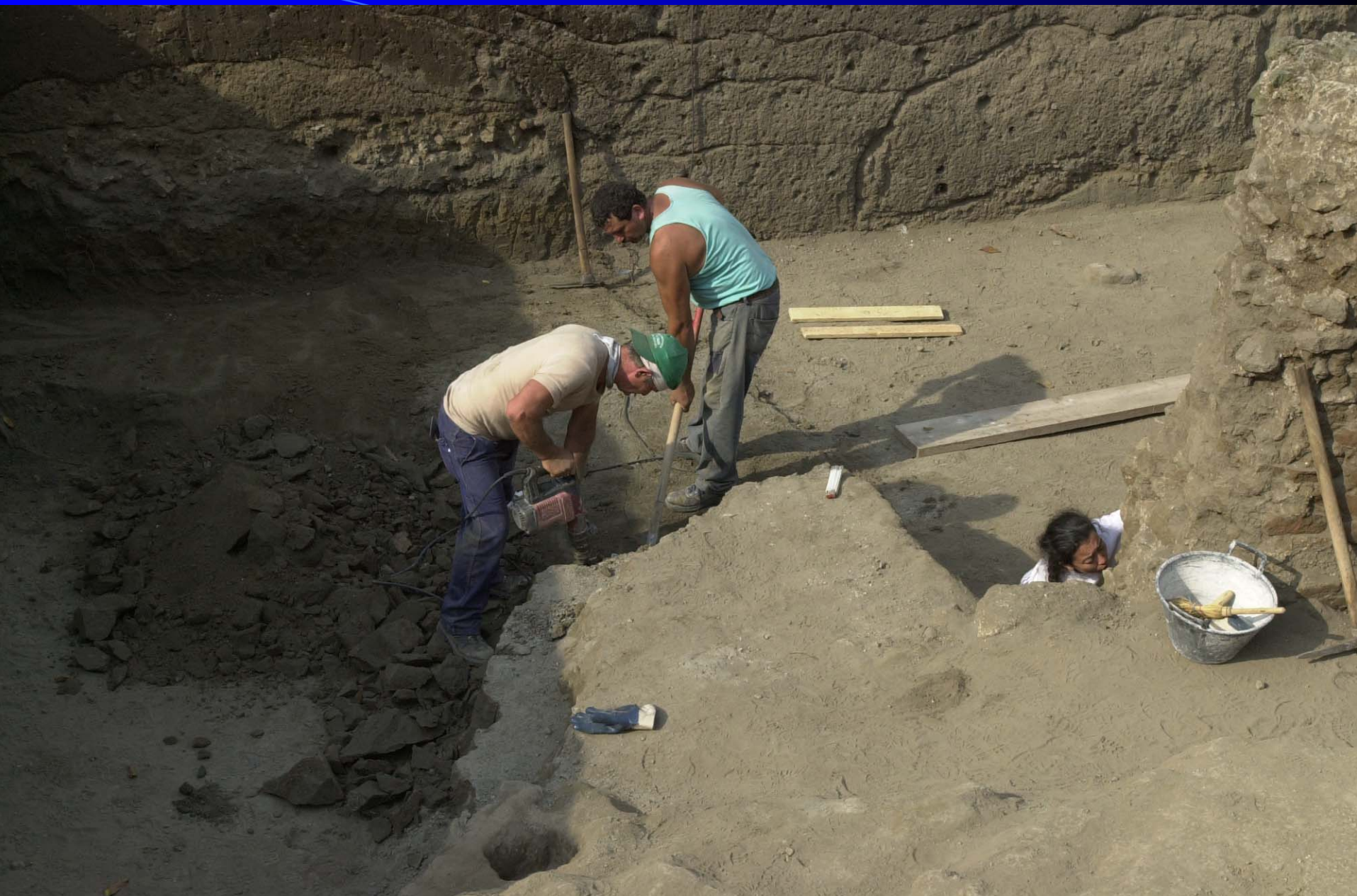
削岩機による掘削 09/2002
