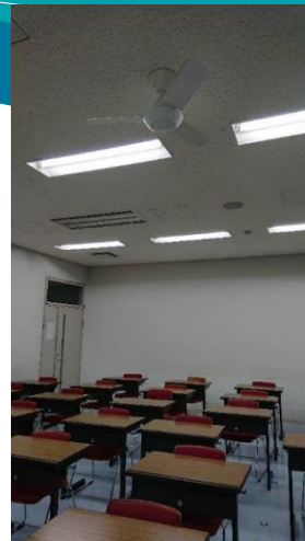
3号館 天井ファン設置
